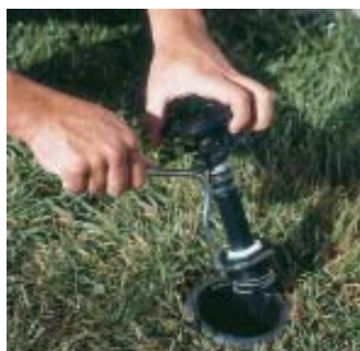
1. Smontare l'interno dell'irrigatore attuale.
