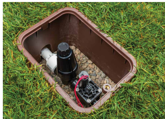
PCZ-101 instalado en una arqueta polivalente
